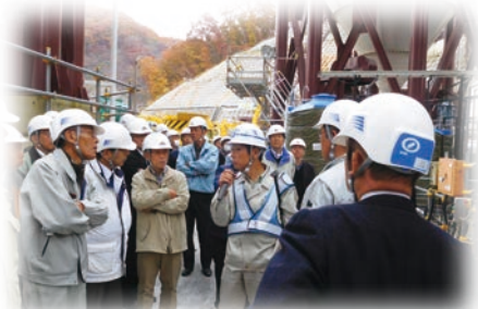
ハツダム工事現場
