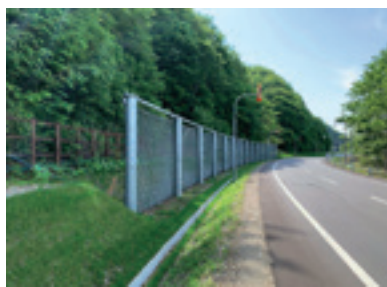
法尻に設置した事例
