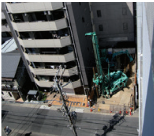
【狭隘地施工の事例】
