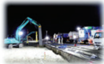
空港の液状化対策
