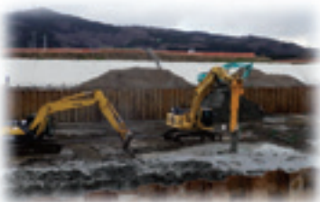
樋門・樋管基礎の支持力増加
