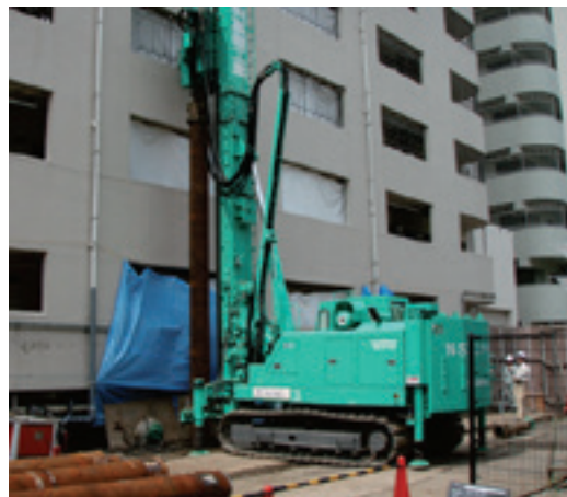
【近接施工の事例】
