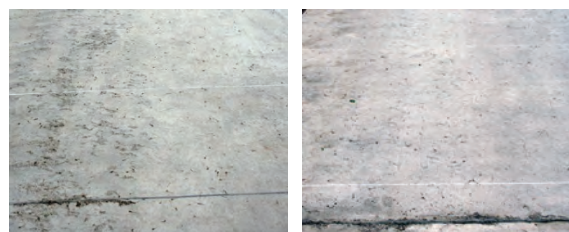
PVA 繊維補強 普通コンクリート a) 1年経過時(2014年)
