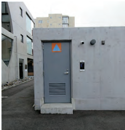
写真-1 中長期的避難施設としてのモデルルーム（地上外部から地下への入口部）
