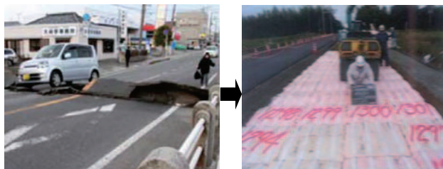
写真-8 液状化による道路被害とD・Boxによる対策工
