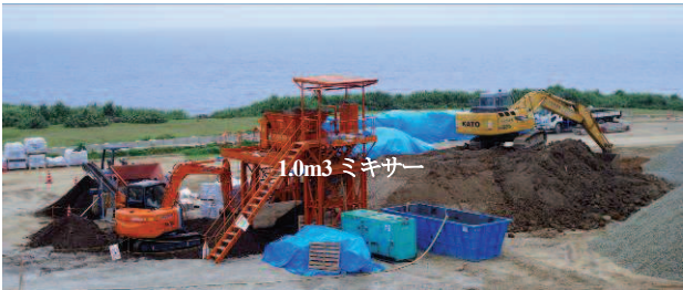
図三 1.0m 3 の生育基盤製造プラント
