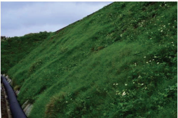
図-8 本施工の調査区の全景 2
