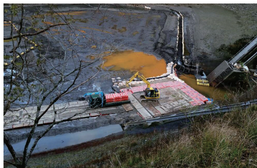
写真-7 仮設道路と作業ヤードの状況
