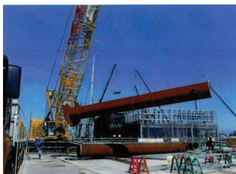
図-12 回転貫入杭施工状況（杭吊り込み）
