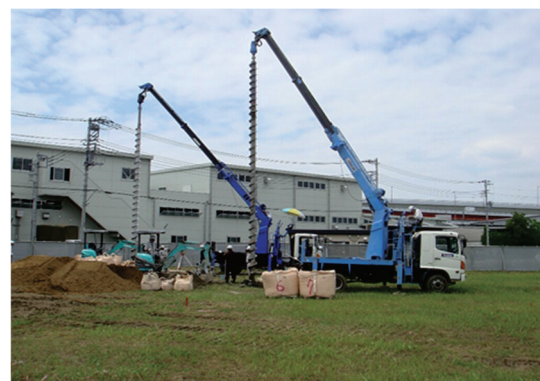
写真-1 SST 工法による施工の様子
