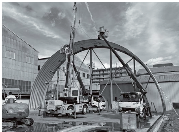
写真-2 建方状況
