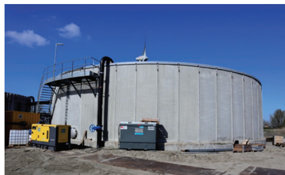
写真-9 オランダ ゼーラント州廃水処理プラント工事
