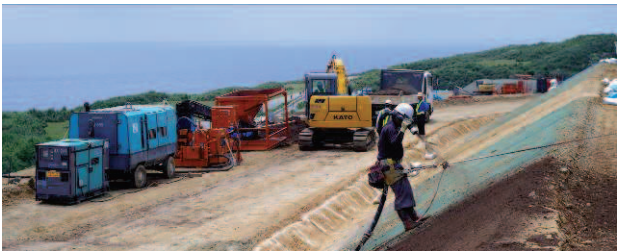
図四 吹付状況(分離型吹付プラント)
