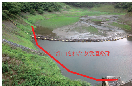
写真-5 ダム湖底部の仮設道路計画
