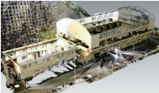
図-6 調査対象建物B棟、C棟の全体点群データ
