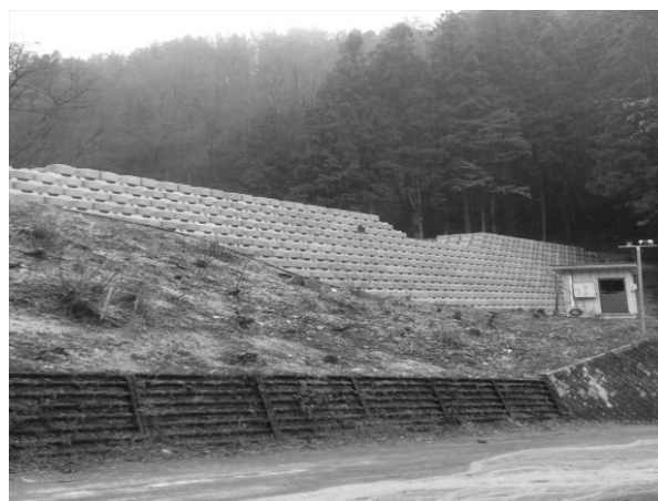
図-1 ブロック堰堤の施工事例
