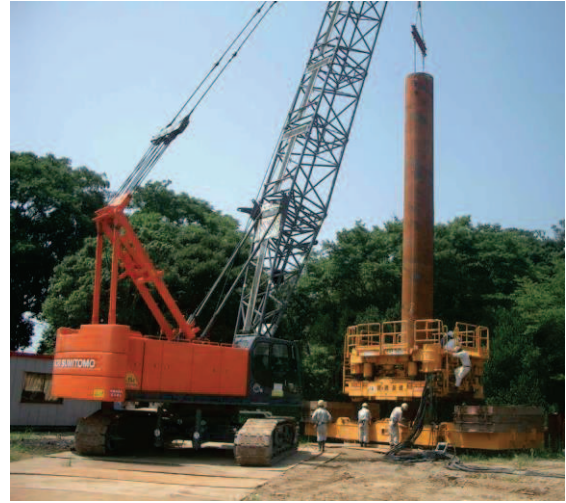
図-4 施工機械（全周回転機）
