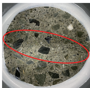
写真－4 ひび割れ発生状況
