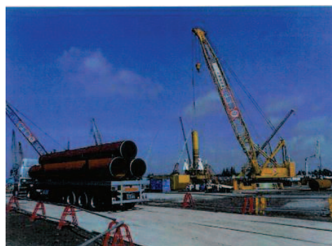
図-11 回転貫入杭施工状況（搬入）
