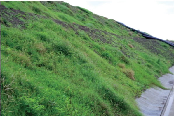
図-7 本施工の調査区の全景 1
