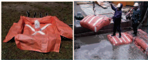
写真-1 D・Box-LS（左）と施工状況（右）
