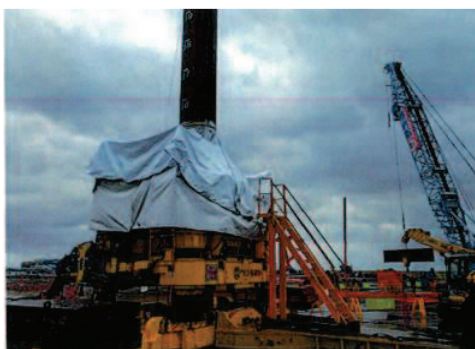
図-13 回転貫入杭施工状況（貫入）
