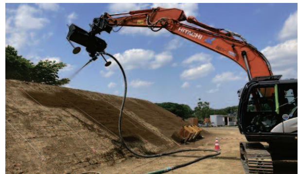
図-13 スロープセイバー吹付状況
