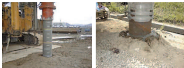
図-6 施工中の地表面
