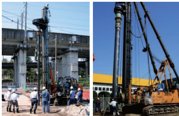
小型機 3点式杭打ち機 図-3 施工機械（クローラ式杭打ち機）
