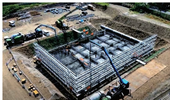
写真-8 札幌市豊平川水道水源保全管理センター新設工事
