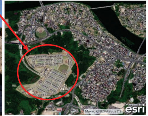
周囲に教育施設、住宅地が近接
