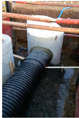
雨水排水工事 Φ700
