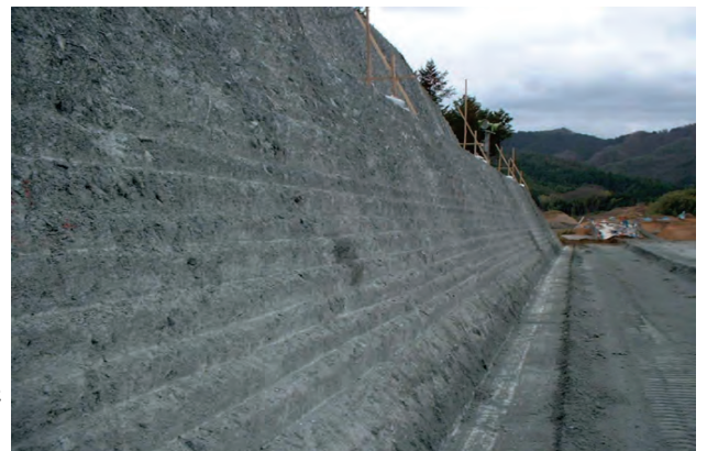
安定した階段状法面
