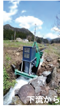
下流左岸から
