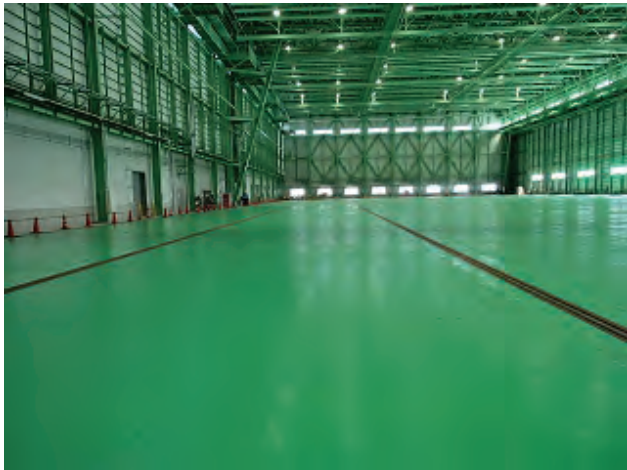
格納庫標準塗装 <SSコートⅡ+ⅢNS工法>
