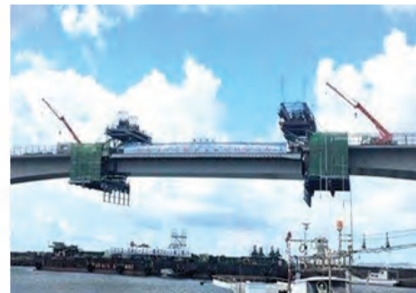
沖縄西海岸道路浦添北道路/牧港高架橋
