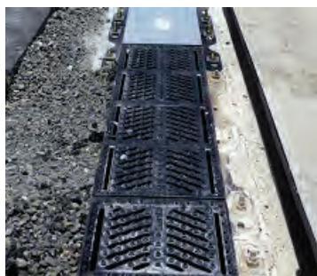
破損した側溝グレーチングの取替施工
