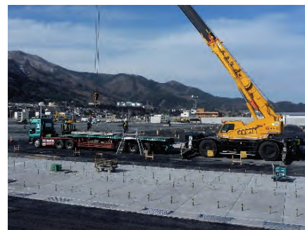
大船渡港施工状況
