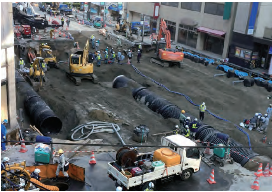
博多駅前 道路陥没事故復旧工事 Φ2000
