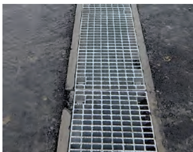
破損した側溝グレーチングの取替施工
