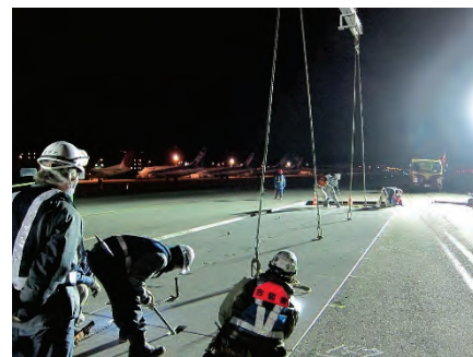
福岡空港施工状況
