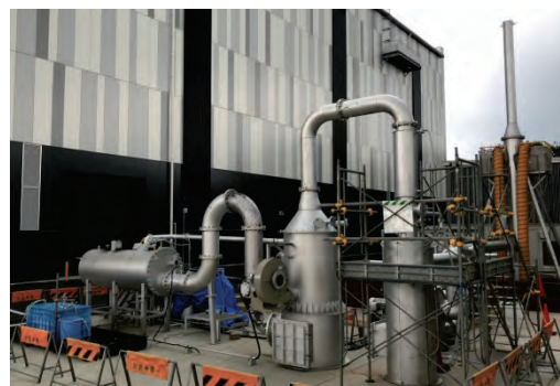
写真1 実証試験状況
