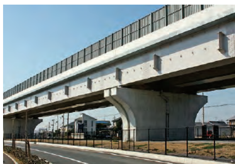
東播磨南北道(水足新辻第5高架橋)
