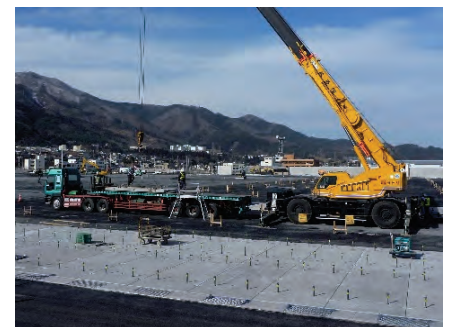
大船渡港施工状況
