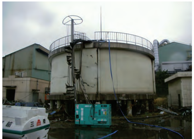
津波を耐え抜いたPCタンク
