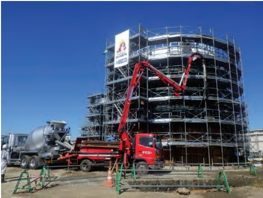
(3) PC壁のコンクリート打設
