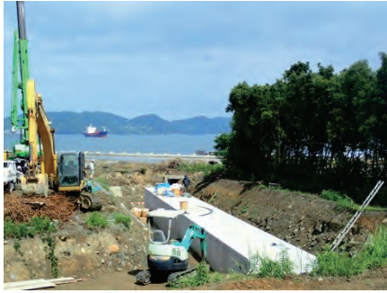
①クロロガード配合ボックスカルバート B2.5×H2.0, 施工延長115m
