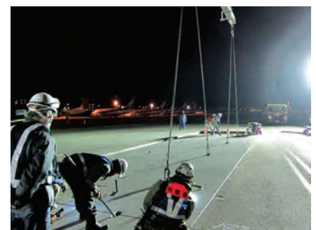
福岡空港施工状況
