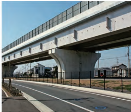
東播磨南北道(水足新辻第5高架橋)
