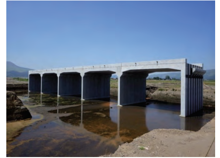
③Max Box+(5連) B(9.3×5連)×H5.8, 施工延長8m
