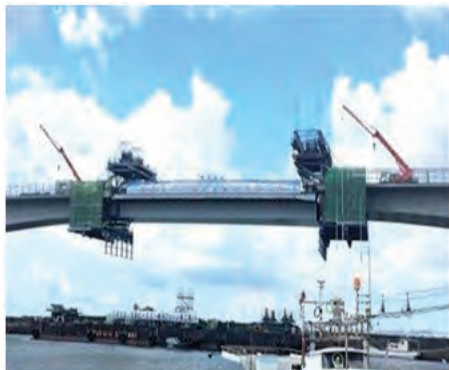
沖縄西海岸道路浦添北道路/牧港高架橋
