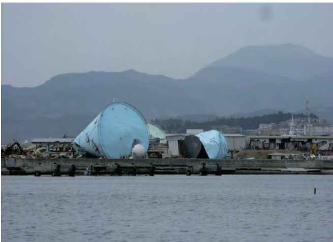
津波で被害を受けた燃油タンク
