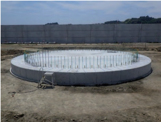
(3) PC壁のコンクリート打設
