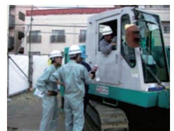
⑧支持層確認後打ち止め
