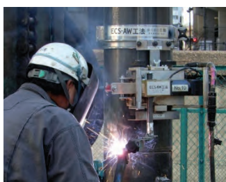
⑥杭の接続
