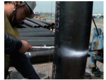
④鉛直確認
