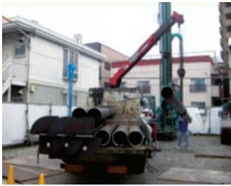
①杭打機・杭材搬入
