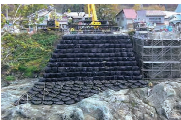
・重機足場として採用
