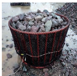
・袋を型枠にセッティング、ロープを結べば完成
