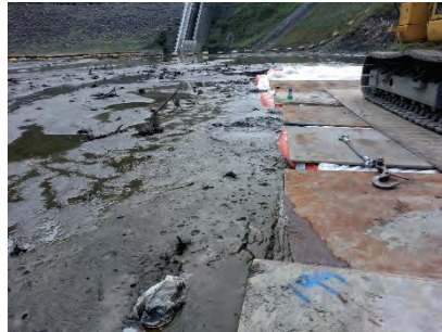
ダム底の仮設道路事例
