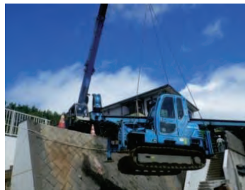
陸上クレーンによる現場搬入出
