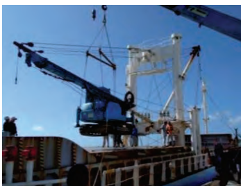
運搬船による施工機の海上輸送
