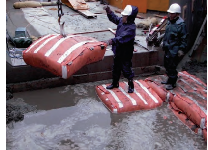
擁壁下部の地盤補強事例
