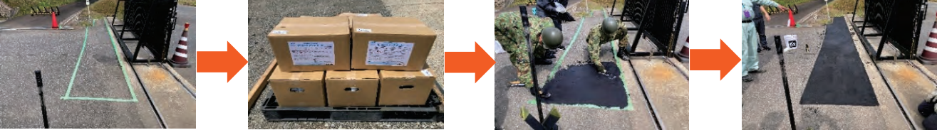
【事例3】 航空自衛隊 芦屋基地 : 排水溝まわりのアスファルト段差修正
