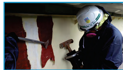
IH式RPR装置による被膜除去の状況
