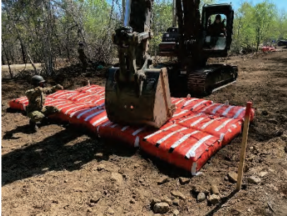
演習地内の路床補強事例
