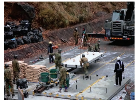
陸上自衛隊員による施工状況
