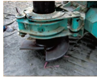
③杭芯セット
