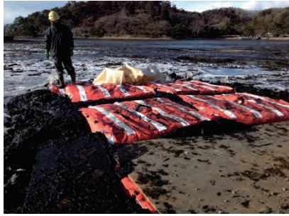
ため池内の仮設道路事例
