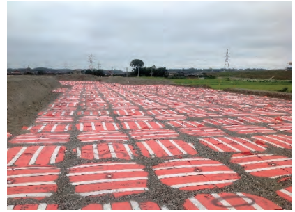
公共施設の地盤補強事例
