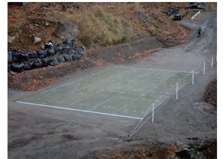
日出生台演習場 施工完了状況
