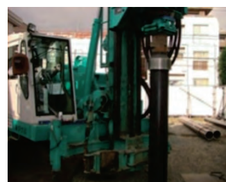
⑦中上杭回転埋設
