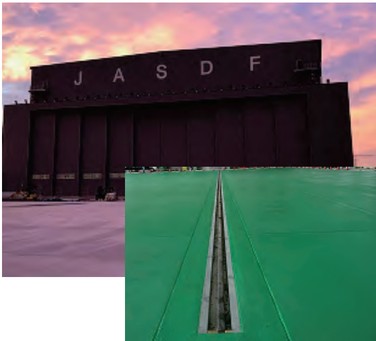
格納庫床標準塗装 <SSコートⅡ+ⅢNS工法>
