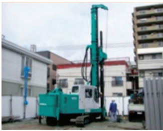
⑤下杭回転埋設
