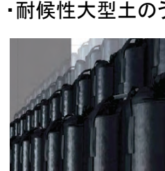
・袋を型枠にセッティング、ロープを結べば完成
