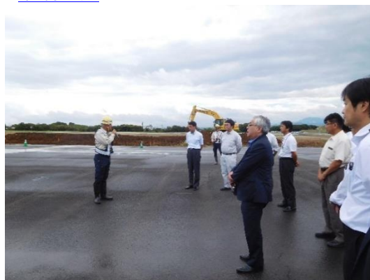
写真-8 仮設滑走路工事現場の見学
