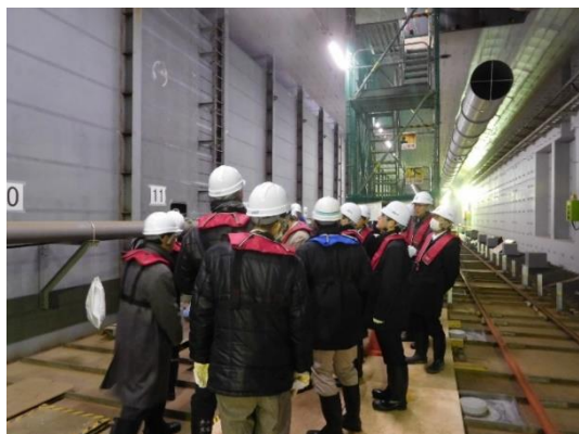
写真-5 沈埋函内部の見学
