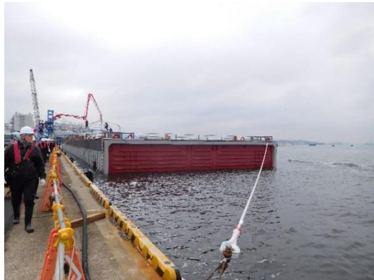
写真-2 15号地木材埠頭に係留された沈埋函
