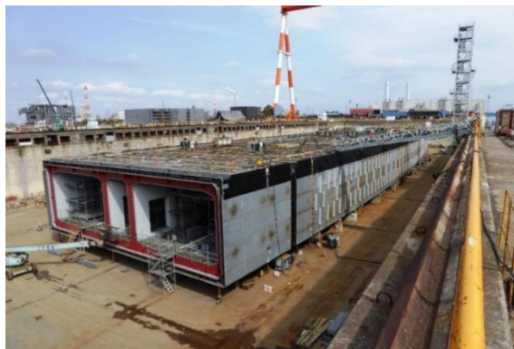
写真-8 ドック内大組立工程状況 (写真提供：(株)三井E&S鉄構エンジニアリング)
